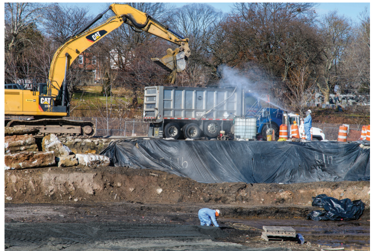
Los trabajadores excavan el suelo y los escombros impactados con cromo en el Sitio 107.
