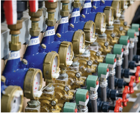
Las bombas inyectan agua modificada con melaza en las aguas subterráneas del terreno de Garfield Avenue.
